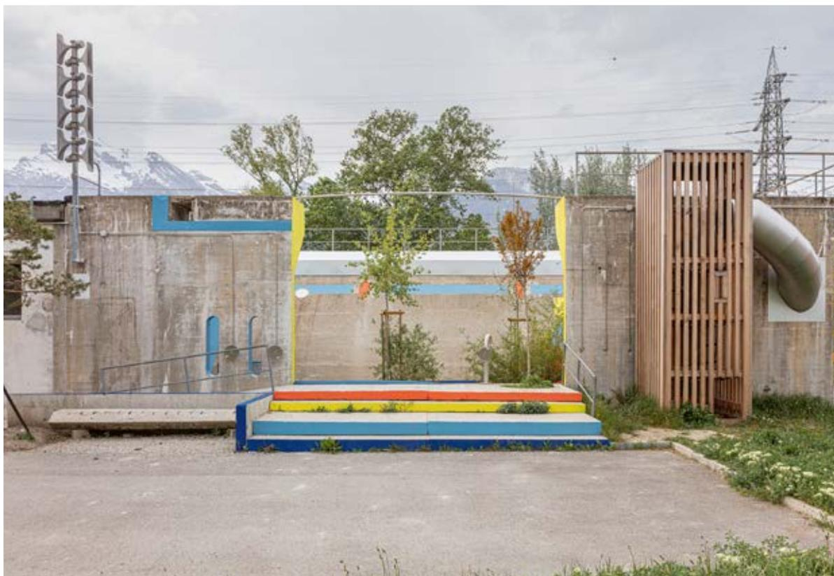
Une grande ouverture est créée en façade sud. La matière extraite des découpes est utilisée pour aménager l'accès vers l'intérieur du projet.
