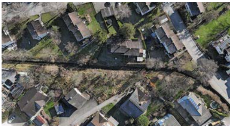
La situation avant la revitalisation.
