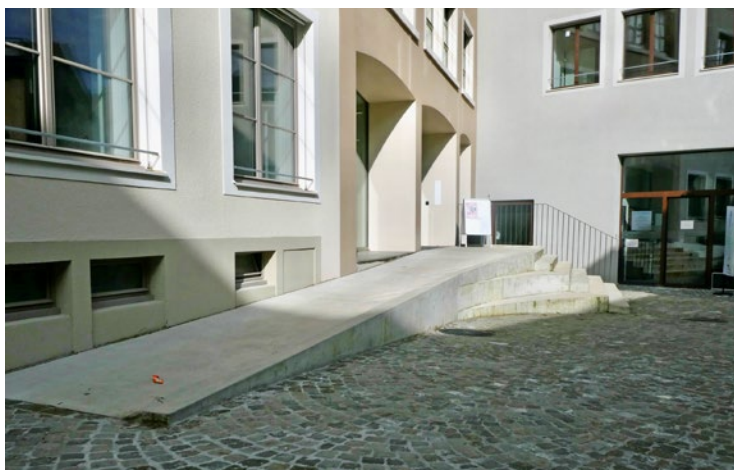
La rampa dell'ingresso principale dell'Effingerhof nel centro storico di Brugg (AG).
