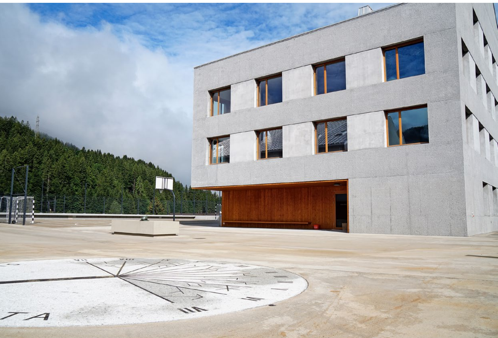
Il Comune ha installato una rete di teleriscaldamento nel nuovo centro scolastico di Klosters Platz.
