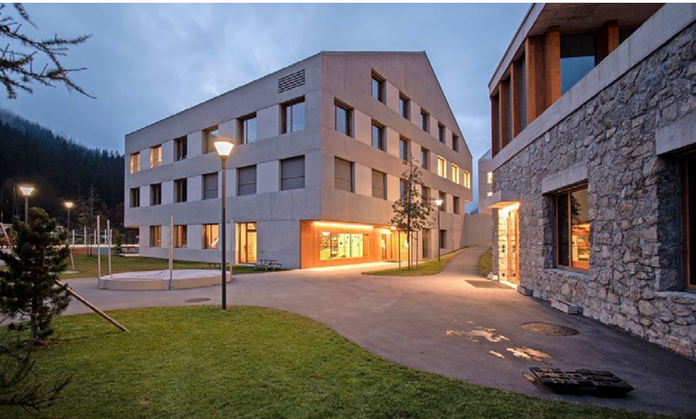
Beim Neubau der Schulanlage Klosters Platz hat die Gemeinde ein Fernwärmenetz installiert.
