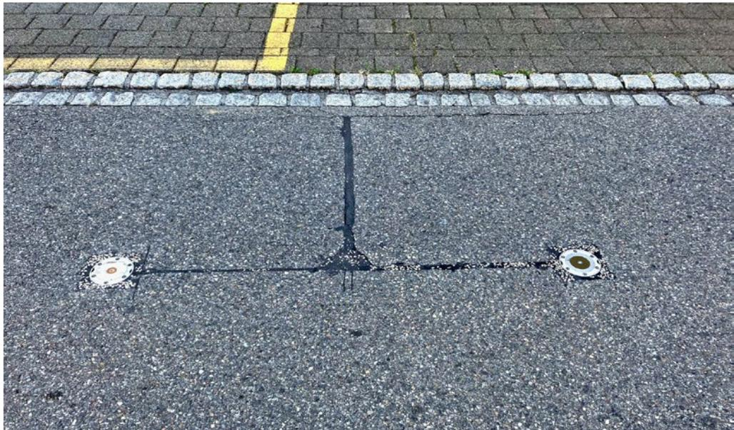
Für die Messung der Bodentemperatur wurden in Berikon (AG) zwei Sensoren im Strassenbelag eingelassen.
