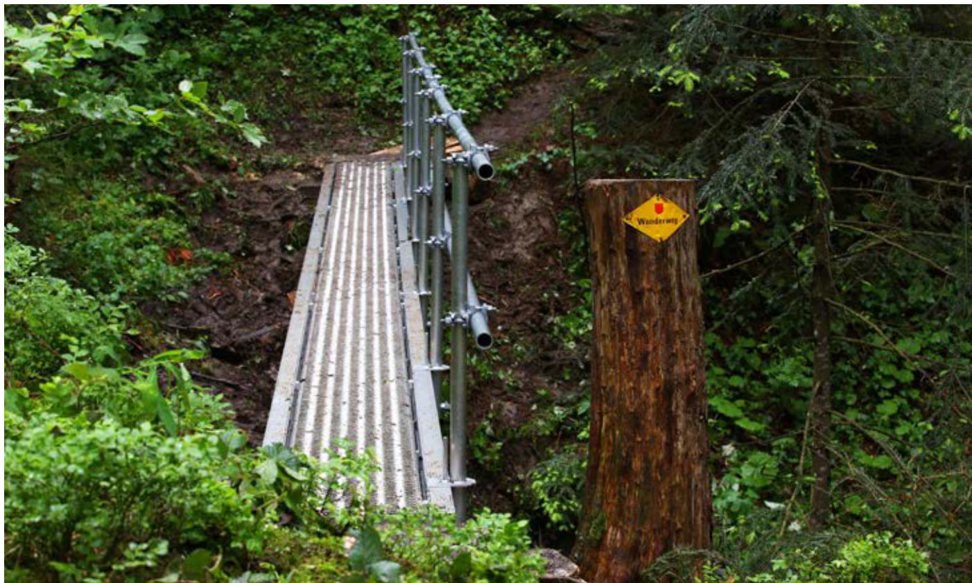
I nuovi ponti a Rothenthurm sono durevoli, antiscivolo e necessitano di meno manutenzione.
