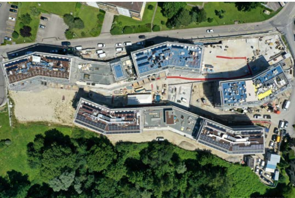
Die Gemeinde Nyon hat ihren Boden im Baurecht einer Genossenschaft überlassen. Diese realisierte darauf das «Ecoquartier du Stand». Bild: zvg/Ville de Nyon/Michel Perret
