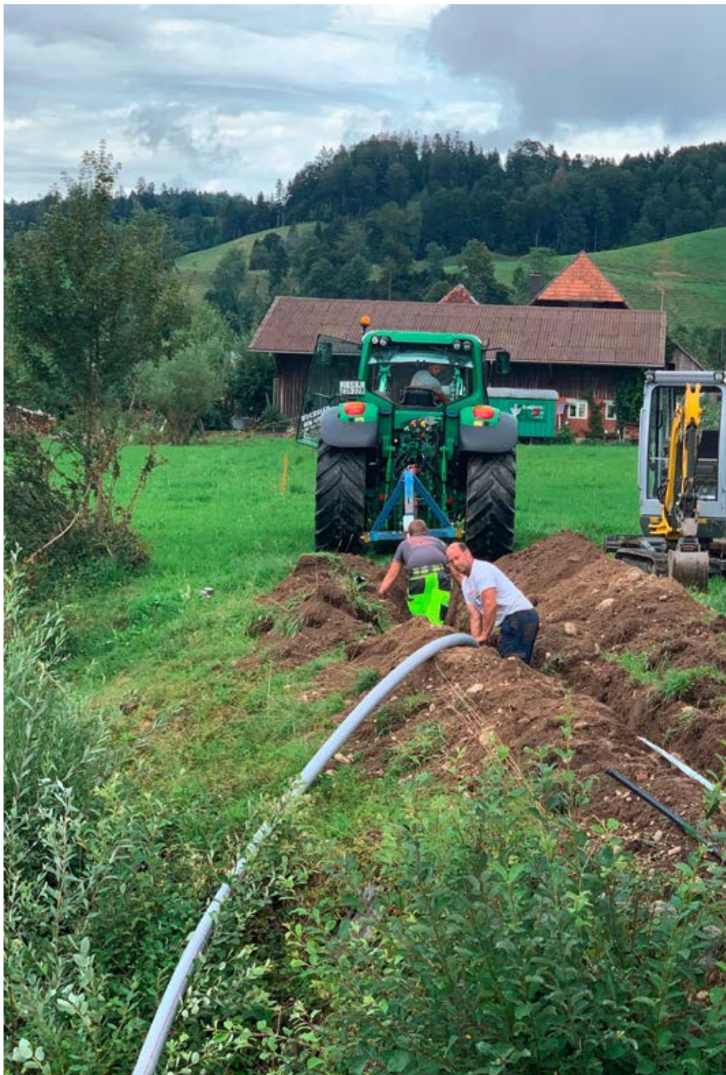
Verlegung von Glasfaserleitungen in Luthern (LU).
