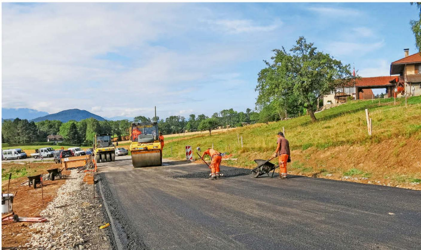
Strassensanierung im Waadtland: Zwischen Mollie und Margot wird recycelter Asphalt eingebaut.
