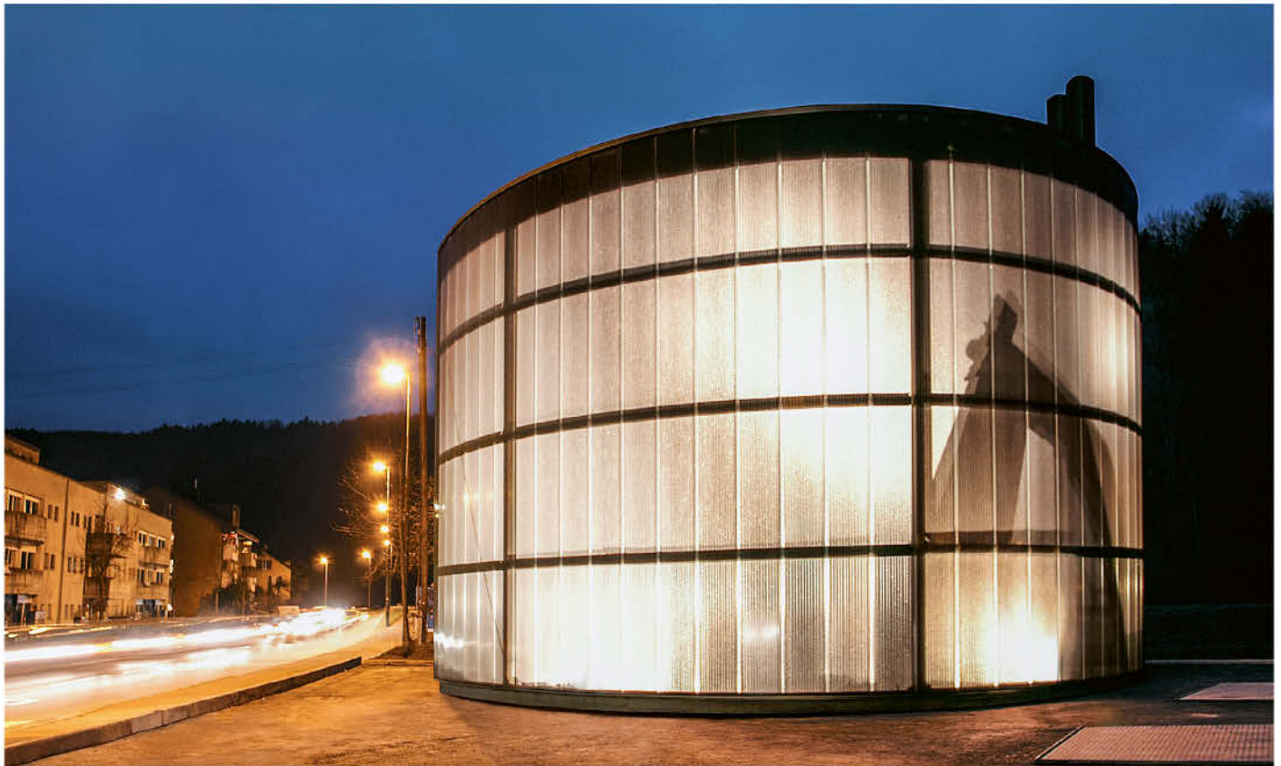
Le centre de chauffage du réseau de chauffage local Sulzer Stadtmitte à Winterthour.
