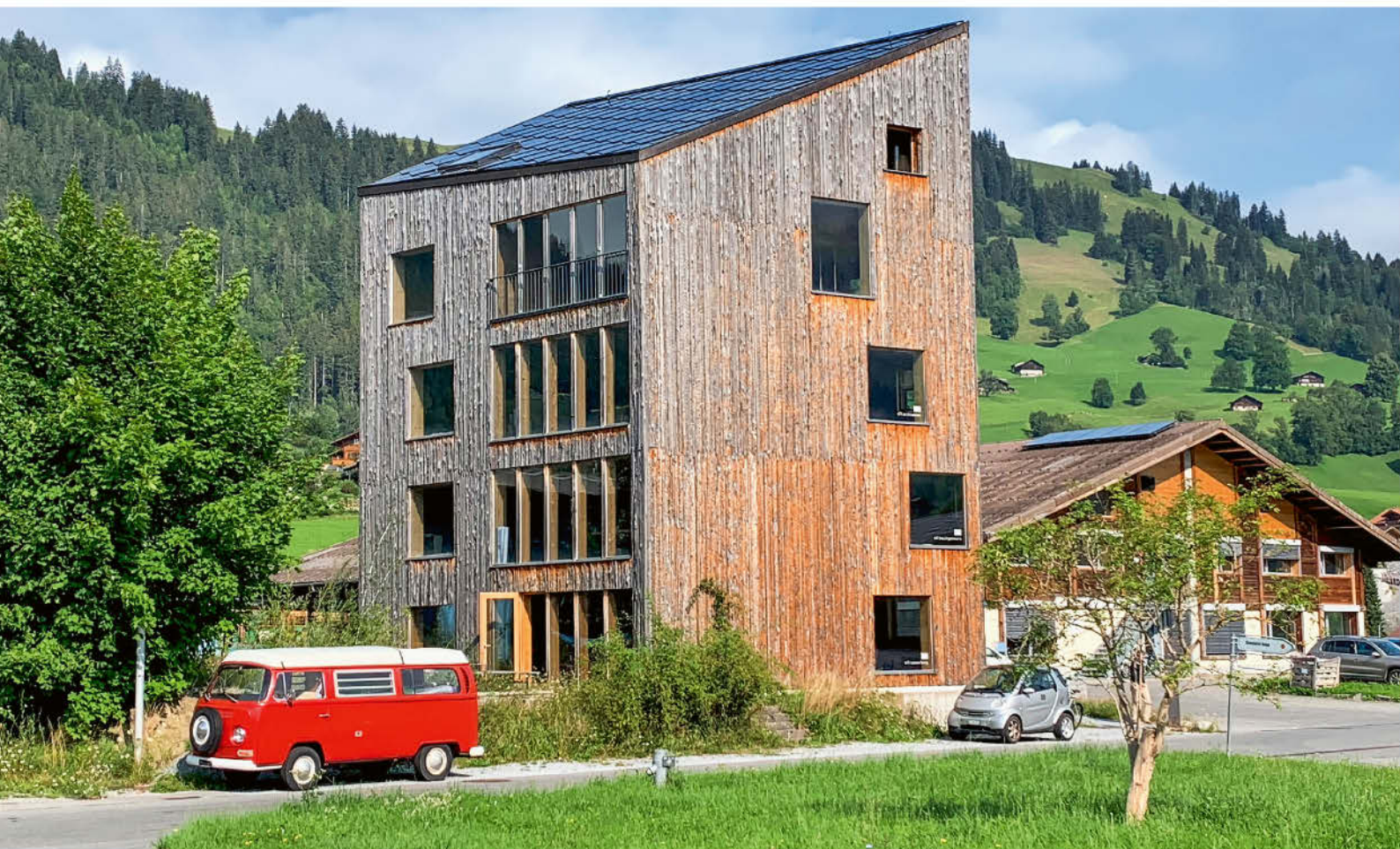
Fünfeckig und aus Holz, Beton und Stampflehm gebaut: das heizungsfreie Wohn- und Bürohaus in Zweisimmen (BE).
