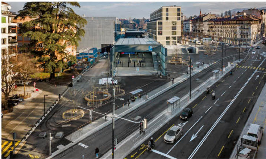
La gare de Genève-Eaux-Vives est un exemple d'une interface réussie. Elle a été construite dans le cadre du projet du CEVA.
