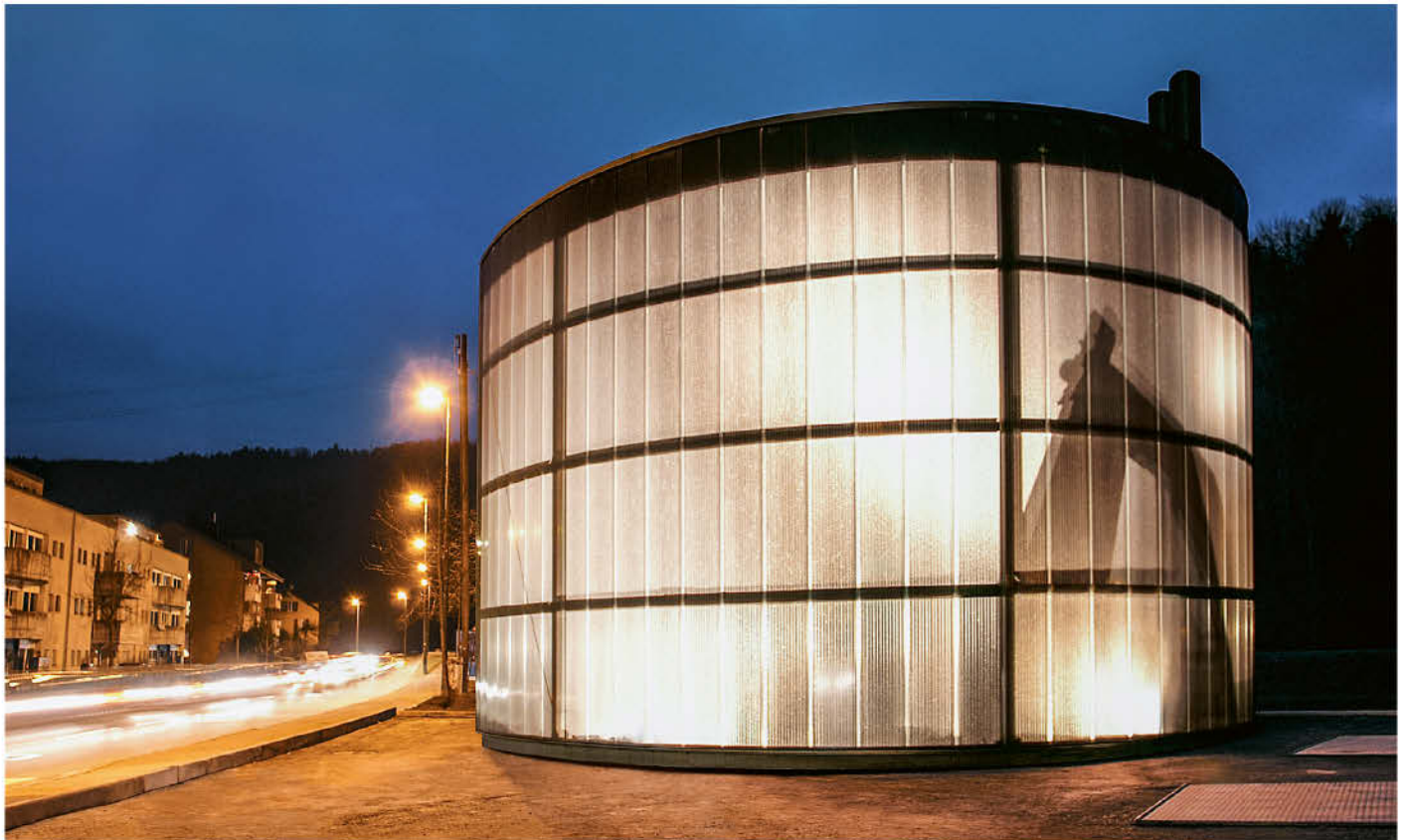
Die Holzschneitzel-Heizzentrale des Quartierwärmeverbands Sennhof.
