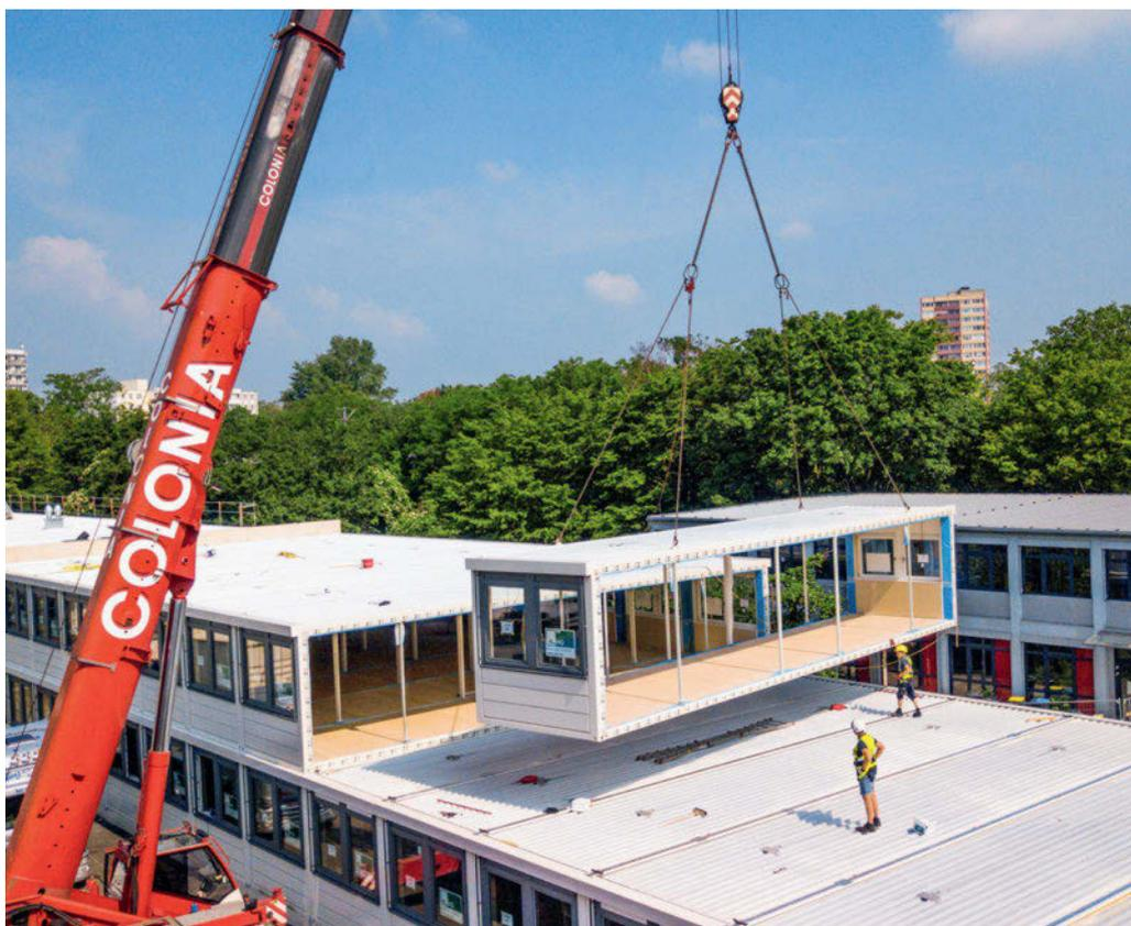
*Modular gebaut, etwa bei Schulen mit schnell wachsendem Raumbedarf, bedeutet auch, dass die Bauteile nach dem Gebrauch demontiert und anderswo wieder genutzt werden können.*
