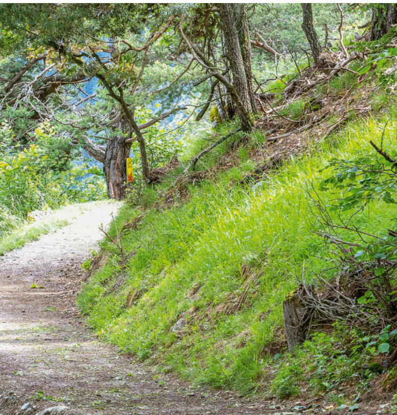
Il tracciato appena consolidato si snoda nel bosco. Il terrazzamento riduce la pendenza del percorso tra il 12% e il 15%.
