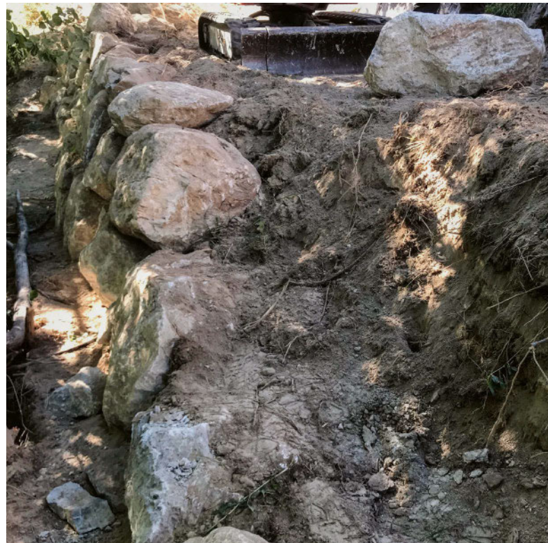
Le tracé nouvellement consolidé serpente dans le paysage. Des terrasses ont été créées pour réduire la pente du chemin à 12%.
