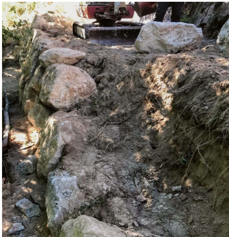
Il tracciato appena consolidato si snoda nel bosco. Il terrazzamento riduce la pendenza del percorso tra il 12% e il 15%.
