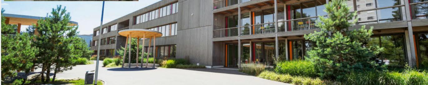
Heute verbraucht das Schulgebäude Hasel in Spreitenbach (AG) trotz einer mehr als doppelt so grossen Energiebezugsfläche nur noch halb so viel Energie wie vor dem Um- und Ausbau (vgl. kleines Bild). Es wird nahezu CO<sub>2</sub>-neutral beheizt.
