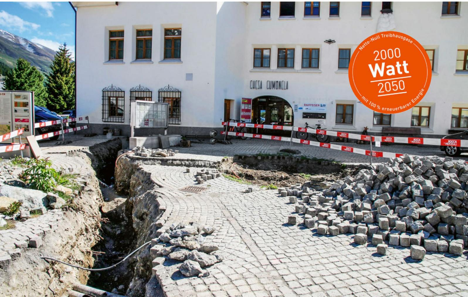
La Punt Chamues-ch: Bald wird es null Emissionen aus den öffentlichen Gebäuden geben. Das Gemeindehaus wird an den neuen CO<sub>2</sub>-freien Grundwasser-Wärmeverbund angeschlossen. Bild: zvg.
