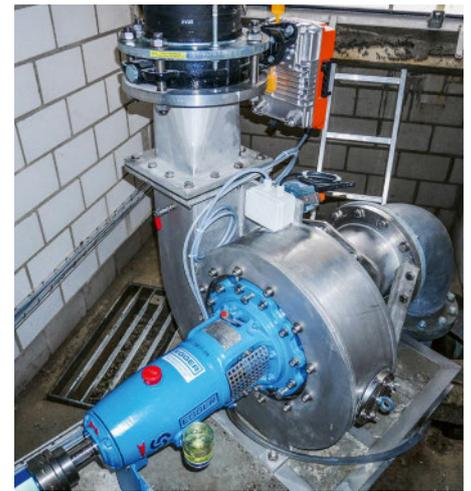
Dans le cadre du projet PaT-Francis, une pompe à eaux usées est utilisée en tant que turbine Francis. Ce type de machine est adapté pour les centrales hydroélectriques avec une puissance et une hauteur de chute moindres. Photo: Hydro Engineering
