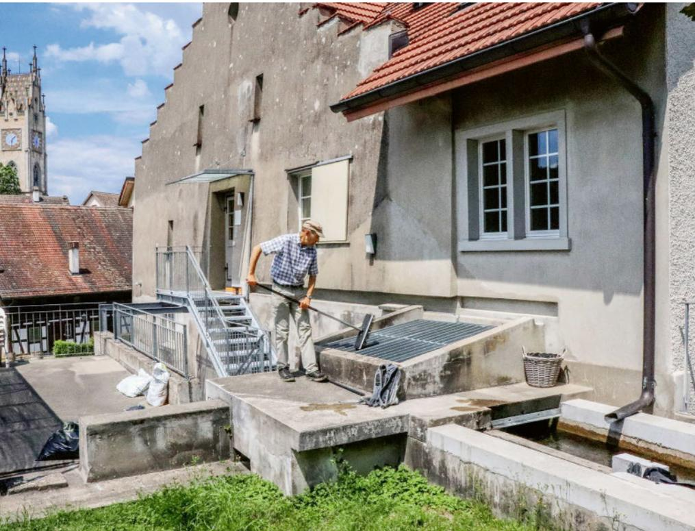
Le Mülibach (à droite) est utilisé pour la production d'électricité dans une petite centrale hydroélectrique. Peter Eichenberger nettoie l'entrée de temps en temps. Une grille grossière permet aux petits mammifères tels que les souris et les hérissons de sortir du canal, une plaque perforée protège les poissons.
