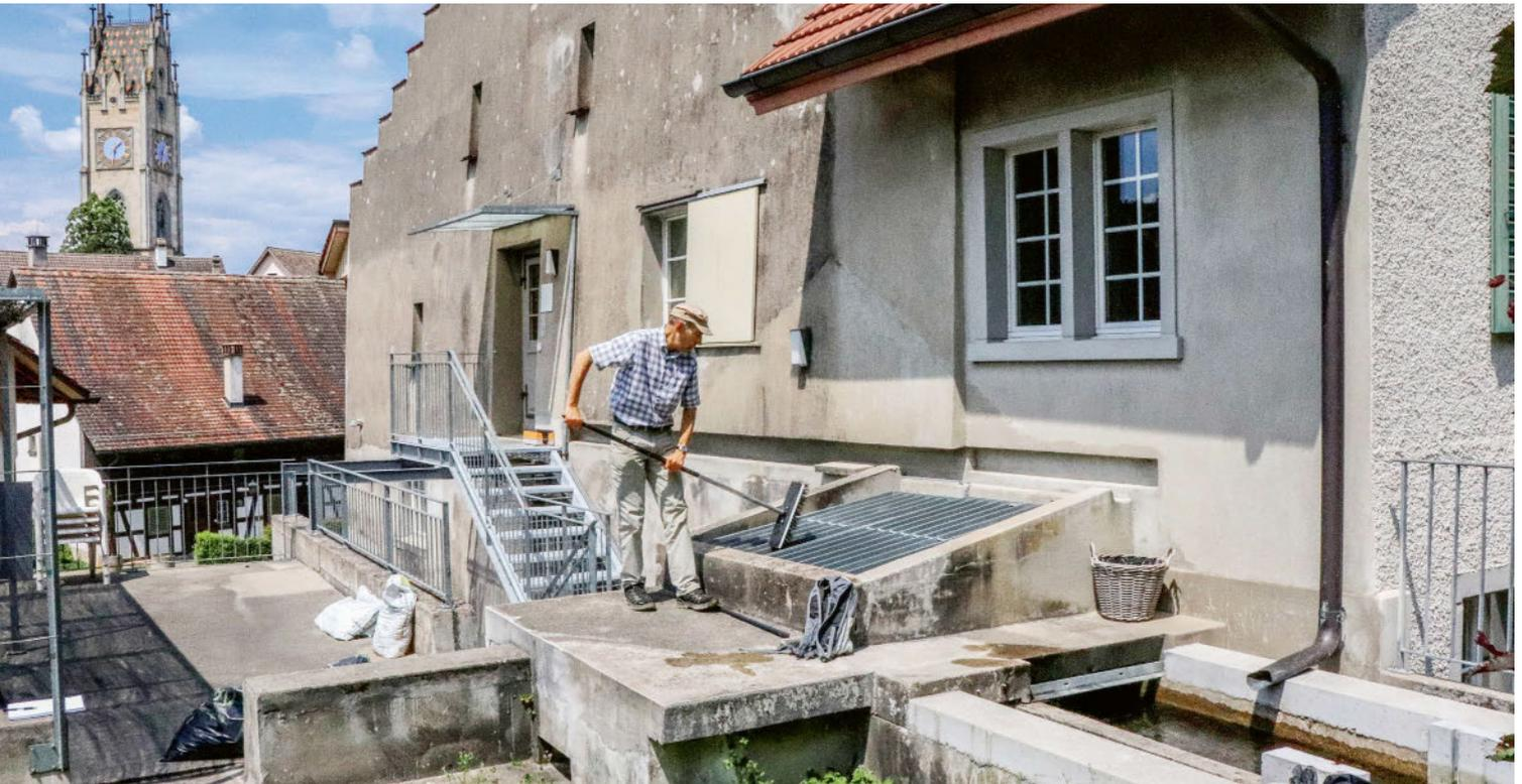
Der Mülibach (rechts) wird in einem Kleinstwasserkraftwerk zur Stromerzeugung genutzt. Peter Eichenberger reinigt von Zeit zu Zeit den Einlauf. Ein Grobrechen ermöglicht Kleinsäugern wie Mäusen und Igel den Ausstieg aus dem Kanal, ein Lochblech dient als Fischschutz.
