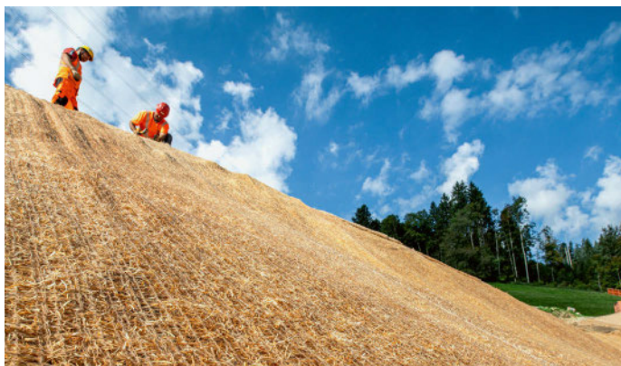
Besonderes Augenmerk gilt der Kombination des Holzwollevlieses mit einer biodiversitätsfördernden, naturgemässen Begrünung aus lokalem Saatgut.
