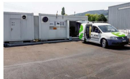
Die Membranaufbereitungsanlage in Reinach (AG) nutzt das Klärgas der ARA Reinach, um daraus Biomethan zu erzeugen, das ins lokale Erdgasnetz der Wynagas AG – ein Gemeinschaftsunternehmen von Eniwa und EWS Energie AG Reinach – eingespeist wird. *Foto: Eniwa*
