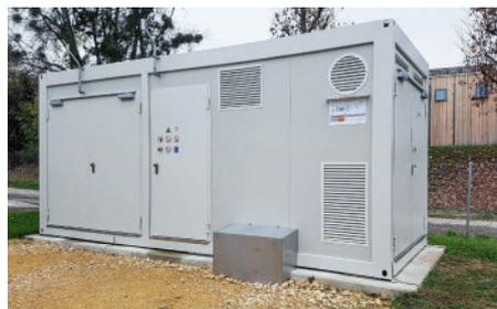
Die Biomethan-Aufbereitungsanlage der Apex AG in ihrer neusten, kompakten Form: Mit der Kleinanlage wird aus dem Biogas der Kläranlage im neuburgischen Colombier Biomethan gewonnen. Dieses wird ins Erdgasnetz des regionalen Energieversorgers Viteos SA eingespeist. *Foto: Apex AG*
