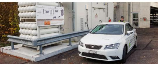
Biomethantankstelle auf dem Gelände der Abwasserreinigungsanlage (ARA) in Schönenwerd (SO): Das Klärgas aus der ARA wird mit einer Membranaufbereitungsanlage (untergebracht im Container in der Bildmitte) zu Biomethan «veredelt». Danach steht das Biomethan in 300-bar-Speicherflaschen (links im Bild) für die Betankung von Gasautos bereit. *Foto: Apex*
