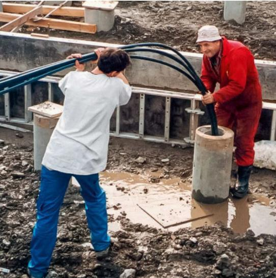
Des tubes en plastique sont insérés dans les fondations durant la construction, puis noyés dans le béton: un aperçu du chantier à Fully. *Photo: màd.*
