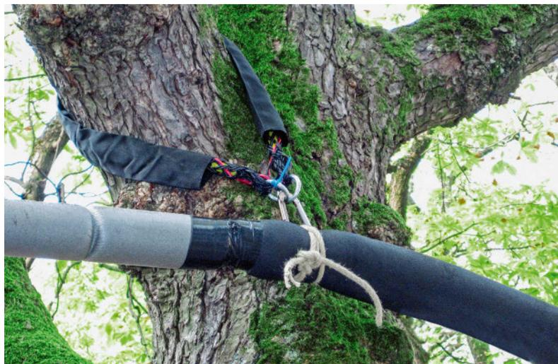
Um zu verhindern, dass Leitungen und Seile beim Verlegen in Baumkronen über Äste gezogen werden und dadurch Schäden verursachen (Bild links), müssen sie mit sogenannten Baumschlingen (Bild rechts) befestigt werden.
