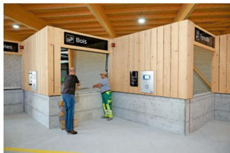
*Du bois et des gravats sont évacués dans des auges par une porte à grande dimension. Les auges sont positionnées sur une balance, sur la base du matériel et du poids le badge correspondant est débité.*
