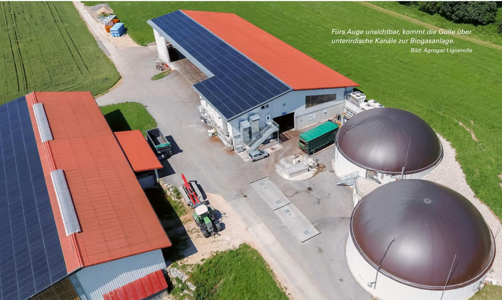
Fürs Auge unsichtbar, kommt die Gülle über unterirdische Kanäle zur Biogasanlage.
