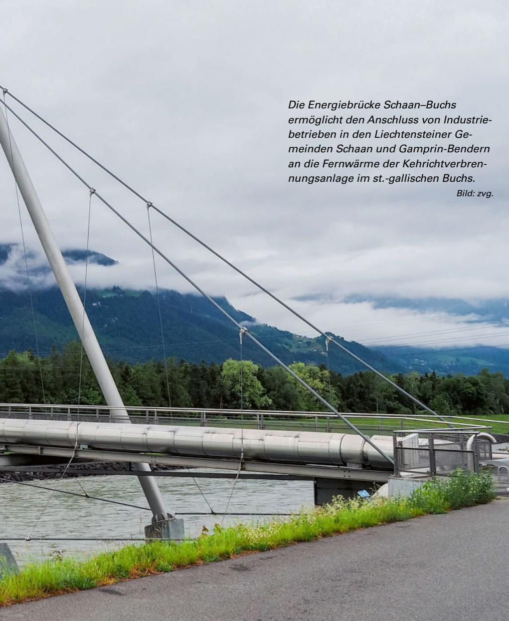
*Die Energiebrücke Schaan-Buchs ermöglicht den Anschluss von Industriebetrieben in den Liechtensteiner Gemeinden Schaan und Gamprin-Bendern an die Fernwärme der Kehrichtverbrennungsanlage im st.-gallischen Buchs.*
