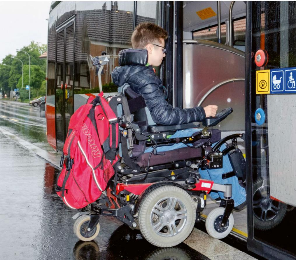
Le Canton de Berne a finalement consenti à construire le «Sonderbord Plus» avec une bordure arrondie en dessous, permettant au bus de se positionner proche du bord.
