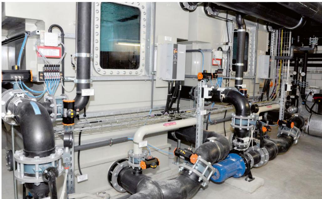
Viel aufwendige Haustechnik im Untergeschoss des 2016 erneuerten Hallenbads Uster: die Überlaufkammer mit Aktivkohlefiltern (rechts), die nachts durch Rückspülung gereinigt werden.
