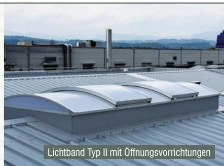
Lichtband Typ II mit Öffnungsvorrichtungen
