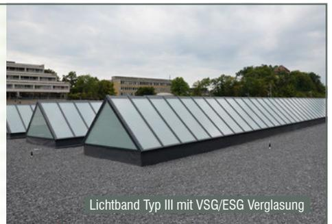
Lichtband Typ III mit VSG/ESG Verglasung
