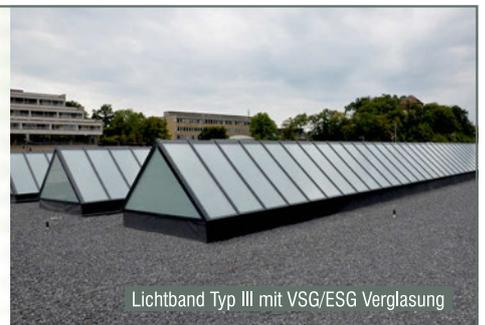
Lichtband Typ III mit VSG/ESG Verglasung
