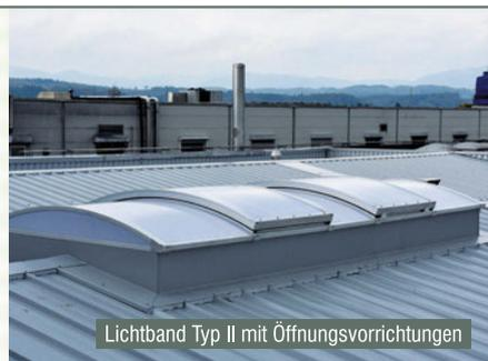
Lichtband Typ II mit Öffnungsvorrichtungen
